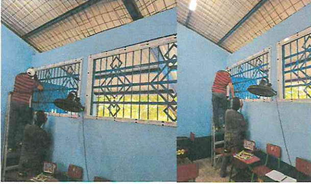
Foto1: Instalación de ventanas de PVC.
